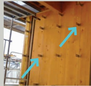
Accroches d'isolant avec équerres (Chalette sur Loing)
