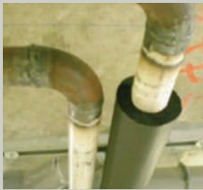
Espacement entre les conduits est très insuffisant pour permettre un calorifugeage satisfaisant (opération de construction de logements sociaux à Tours)
