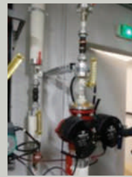
Rénovation d'une école
