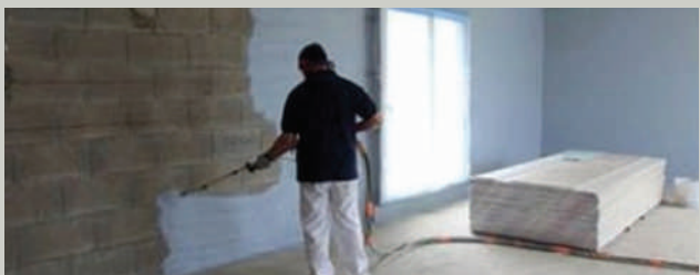
Étanchéifier le mur maçonné par enduit ou par un produit spécifique (type Aéroblue, photo ci-dessus)
