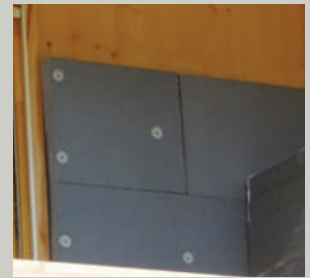
Accroches d'isolant avec chevilles, ITE (Chalette sur Loing)
