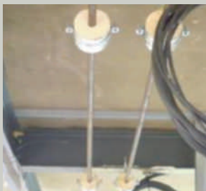
Colliers pré-isolés, mis en place sur opération de rénovation de bureaux à Orléans
