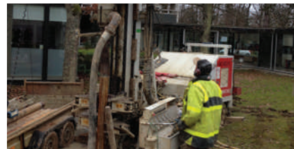
Forage pour l'installation de 3 sondes géothermiques dans le cadre de la rénovation d'un bâtiment du BRGM
