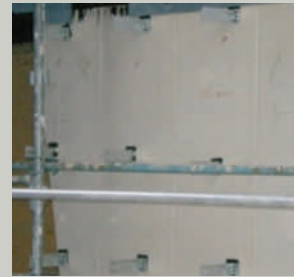
Traitement des ponts thermiques liés aux équerres avec des cales en plastique (CNAV)
